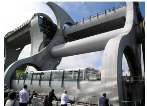
Falkirk: sollevamento dei battelli
